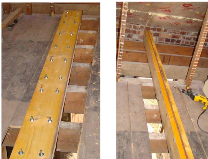
Конструкція підсиленого болтового з'єднання балки
