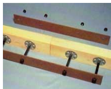
Монтаж бокових накладень
