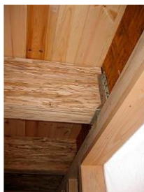
PSL: конструкційні матеріали, подібні до LVL
