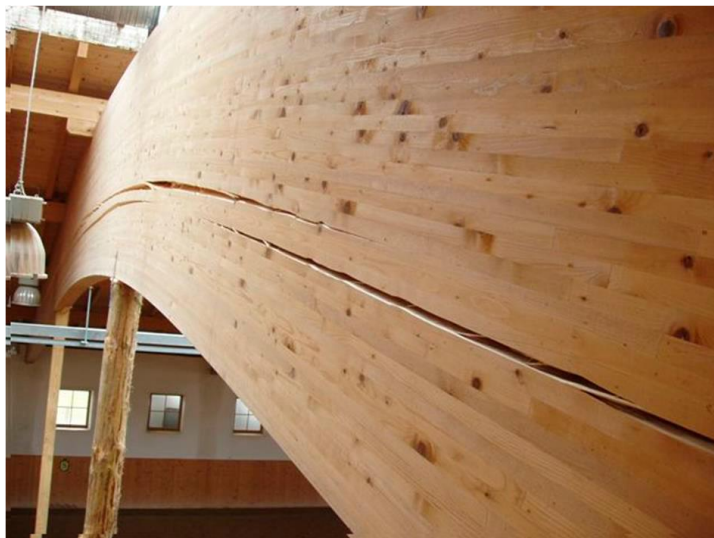
Вигнуті балки - напруження перпендикулярно до волокон
